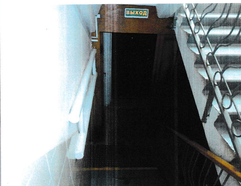
Фото входной двери №1 и тамбура
