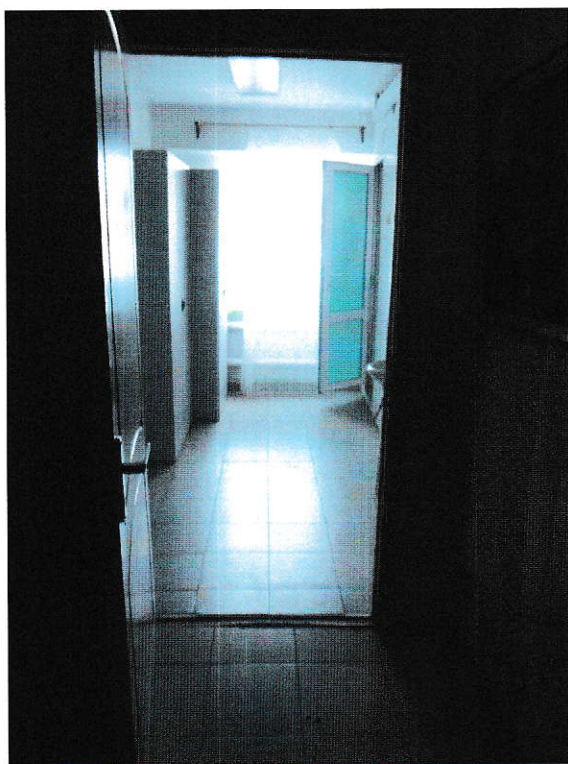
Фото. Общий вид санитарно-бытового блока
